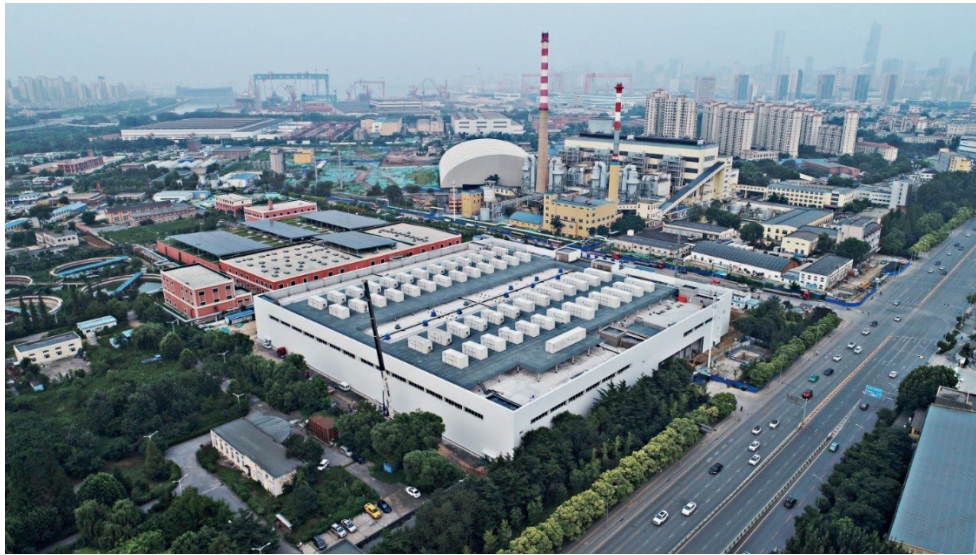
Рисунок 1 – Электростанция Dalian Constant Current Energy Storage Power Station Co., Ltd. с системой хранения энергии
