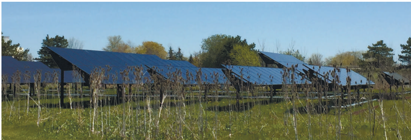
Солнечная станция Университета Баффало
