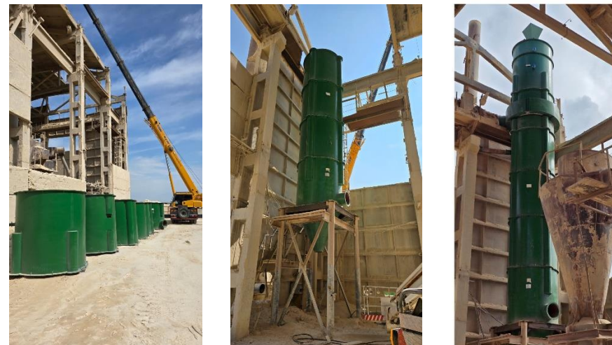
Установка теплообменника, Алга
